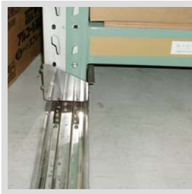
転倒防止用レール
